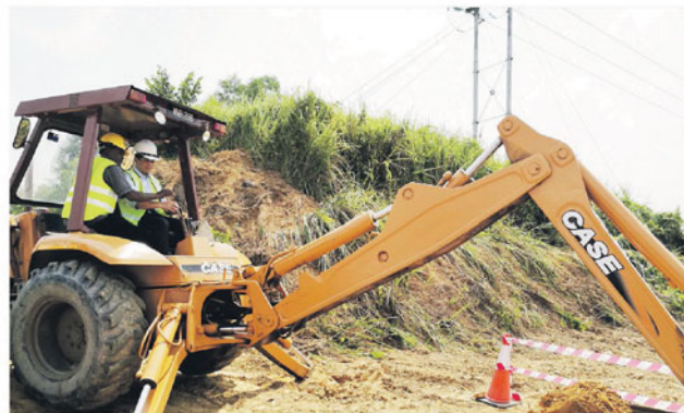
Azmin mengendalikan jentolak sebagai gimik perasmian majlis pecah tanah jambatan di Jalan Batu Arang-Batang Berjantai, semalam.
