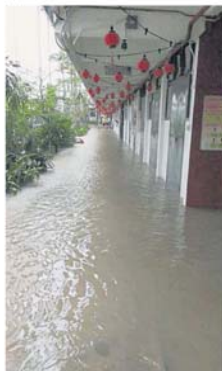
校舍走廊和底楼教室尽是水。
